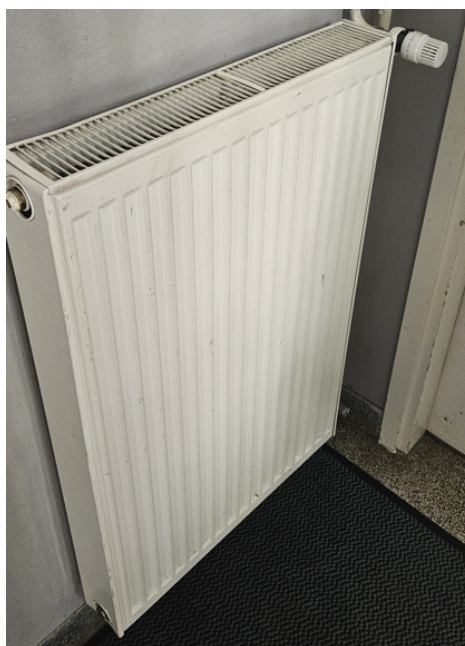
Slika 14: Radiatorsko ogrevanje - nameščeni termostatski ventili
